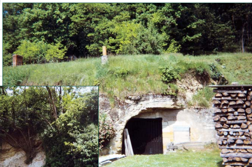
Ci-contre, végétation non maîtrisée, ci-dessus, coteau entretenu.
