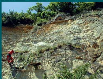
Pose d'écran de protection à mi paroi
