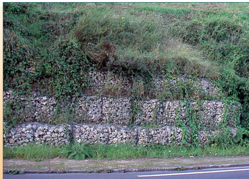
Gabion en stabilisation de pied de talus
