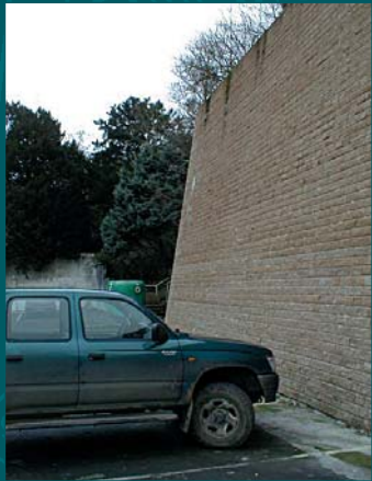
Soutènement par éléments emboîtables (Leromur®)
