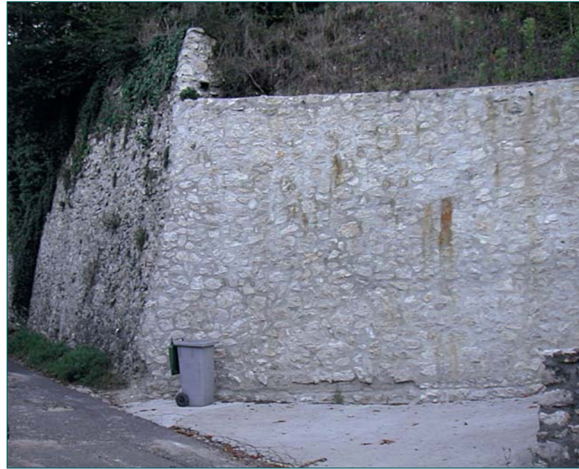
Mur de soutènement restauré
