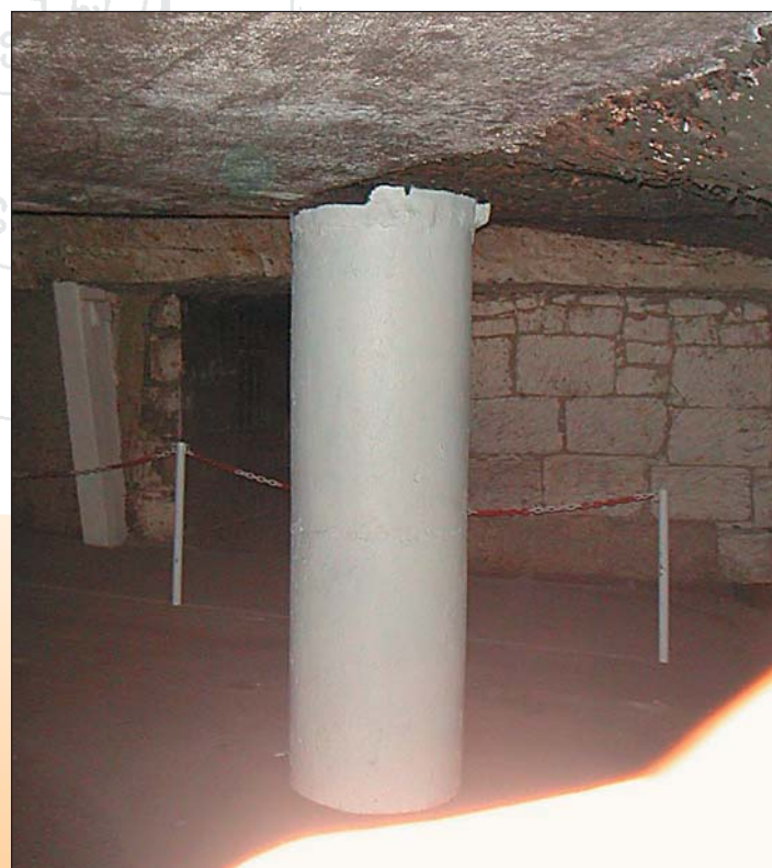
Maçonnerie en pilier de soutènement
