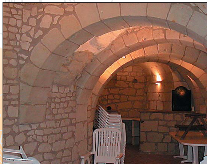
Maçonnerie en arc
