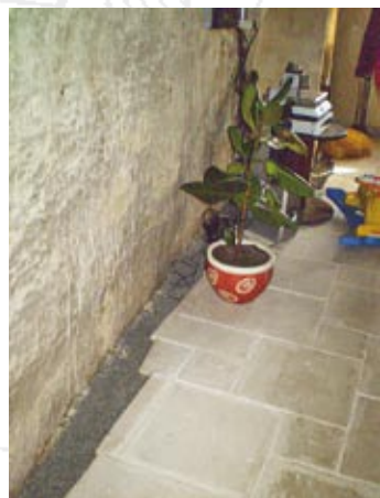
Espace libre entre paroi rocheuse et dalle béton
