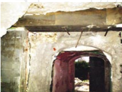
Longrine béton armé autoportée renforçant la voûte
