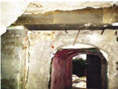
Longrine béton armé autoportée renforçant la voûte
