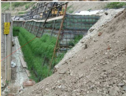
Feutre géotextile pré ensemencé à l'arrière d'un treillis soudé
